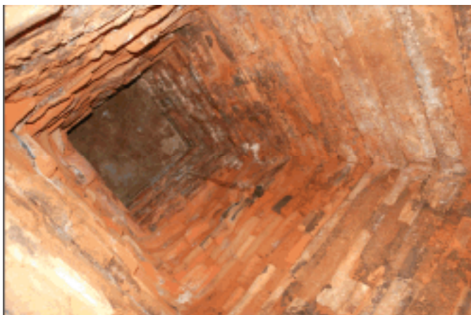
Hình 11. Kỹ thuật vòm-giát-cấp (corbelling) trong nội thất của tháp Nhỏ Phú Hải. Phần trên chóp kết thúc bằng một phiến đá vuông còn nguyên bản. (Ảnh: Trần Kỳ Phương, 2014).
