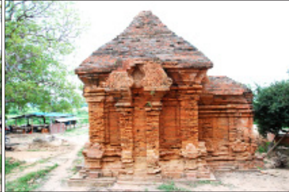
Hình 9. Mặt phía tây của tháp Trung tâm Pô Đàm (nguyên bản) thể hiện cửa giả với vòm cuốn lớn trang điểm các đơn vị họa tiết thuộc giai đoạn giữa của Phong cách Hòa Lai. Phần mái trùng tu vào đầu những năm 2000.
